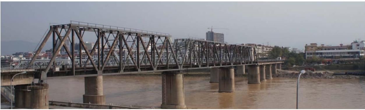
广元铁路钢桥隶属四川成都铁路局绵阳工务段。该桥坐落于横贯广元市中心的嘉陵江上，是连接两岸的重要交通纽带。成都铁路局非常重视广元铁路钢桥的保养维护工作，每年都投入大量的资金与人力用于广元铁路钢桥的保养及翻修，但是该桥梁所使用的醇酸类涂料并不能提供理想的防护效果，维护周期较短。不仅如此，由于醇酸类涂料技术陈旧，需要多道施工，导致每次的修缮周期冗长，并耗费大量的人工。此外，高VOC含量的醇酸涂料在施工过程中会释放出大量的有机挥发物（VOC）及散发出的强烈的刺激性气味，这会给广元市市民的日常生活带来不良的影响。
